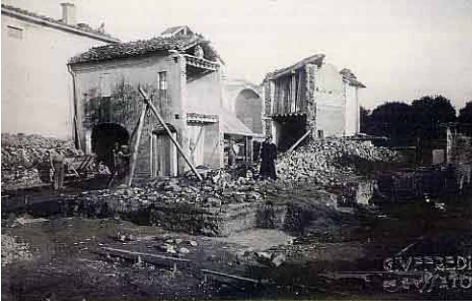
Una fase dell'abbattimento della vecchia chiesa, nell'ottobre 1933. In un anno il pericolante sacello fu sostituito dal nuovo splendido Tempio.
