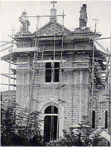
Lo stato dei lavori del Tempio nel giugno 1934. La torre deve essere ancora iniziata.
